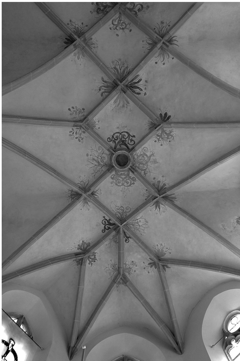
(14) Kamence, klenba presbytáře klášterního kostela. Foto autorka.
