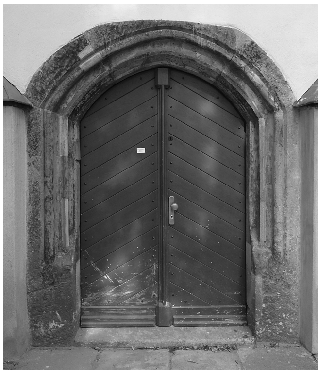
(12) Kamenec, portál v jižní zdi presbytáře klášterního kostela. Foto autorka.
